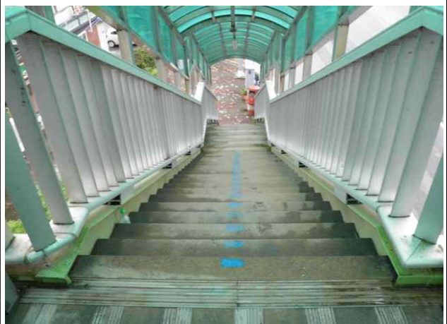
난간 및 연석 전경
