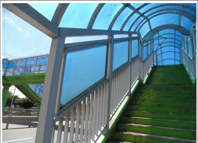
난간 및 연석 전경
