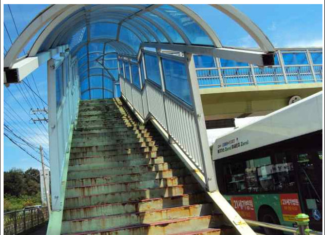
난간 및 연석 전경
