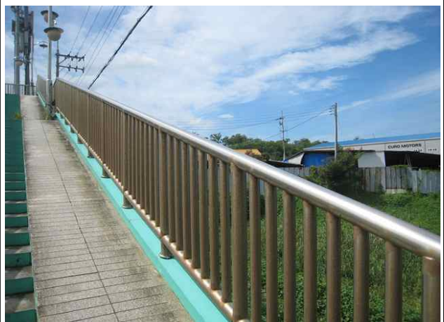
난간 및 연석 전경
