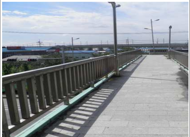
난간 및 연석 전경
