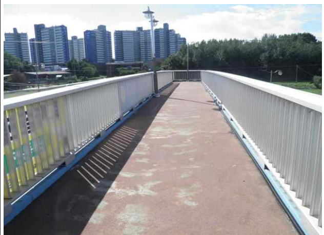
난간 및 연석 전경
