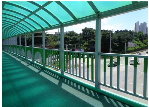
난간 및 연석 전경
