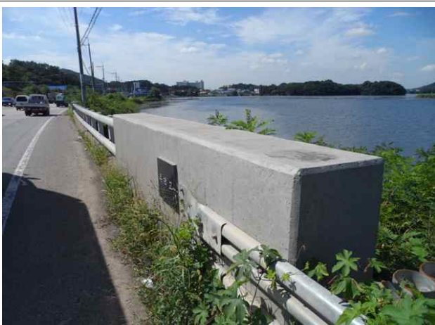
난간 및 연석 전경
