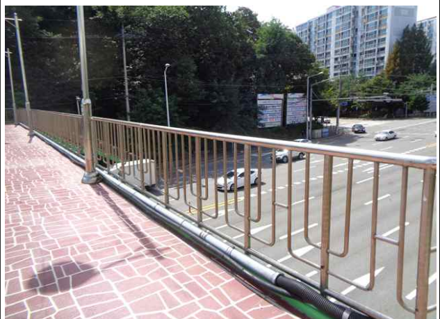
난간 및 연석 전경
